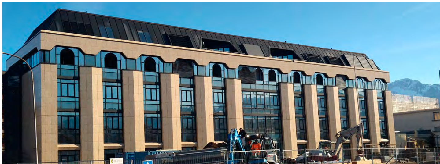
Démolition du bâtiment situé à l'avenue Reller 14
