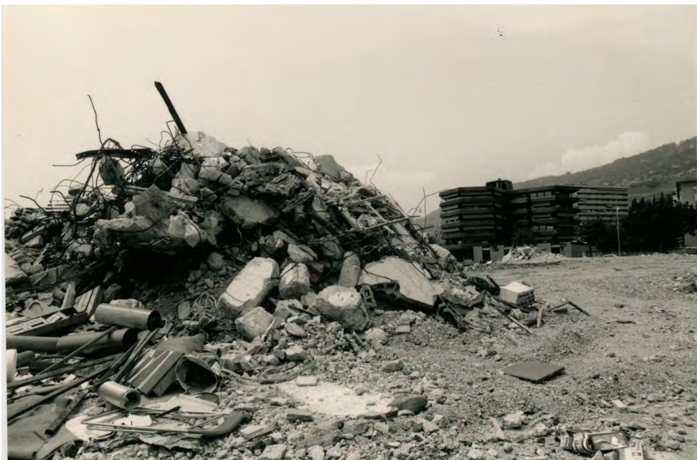
Reller 14 - la démolition de la fin des années 80
